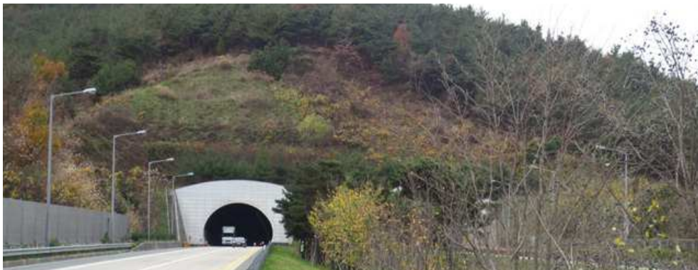
(시점부 절토사면 전경)
